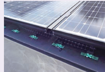
③ 固定金具の貼付
